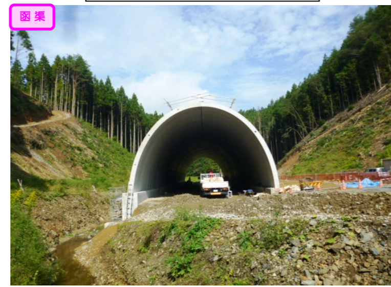
③ 4号函渠工 テクスパン設置完了
