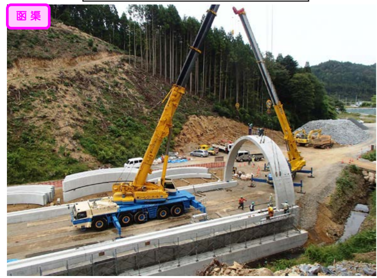
② 4号函渠工 テクスパン設置状況
