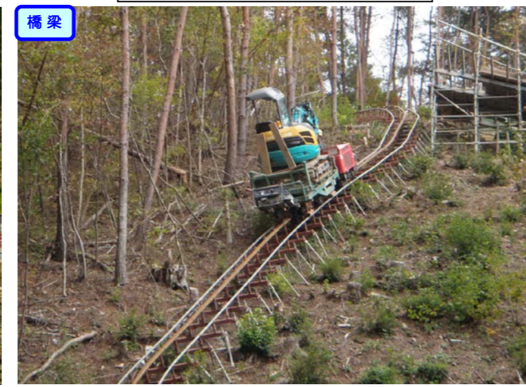
④ モノレール運搬状況 新井田川橋
