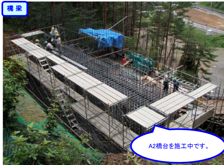
④ A2施工状況
