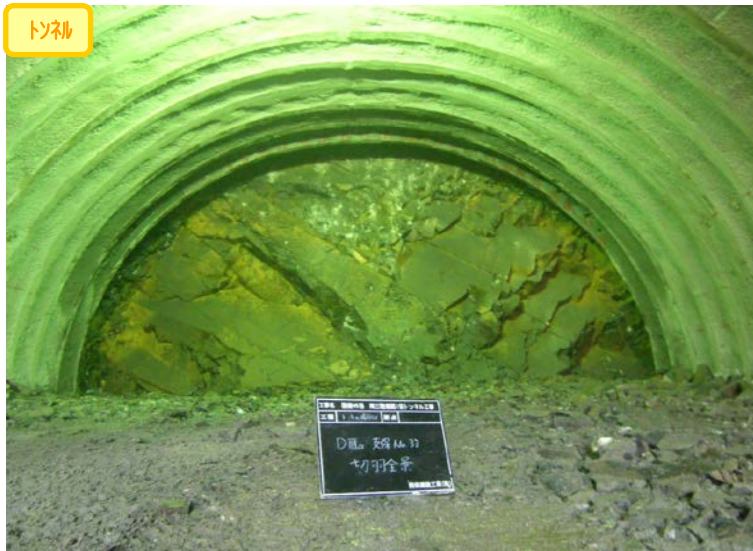
② 南三陸道路1号トンネル 切羽全景
