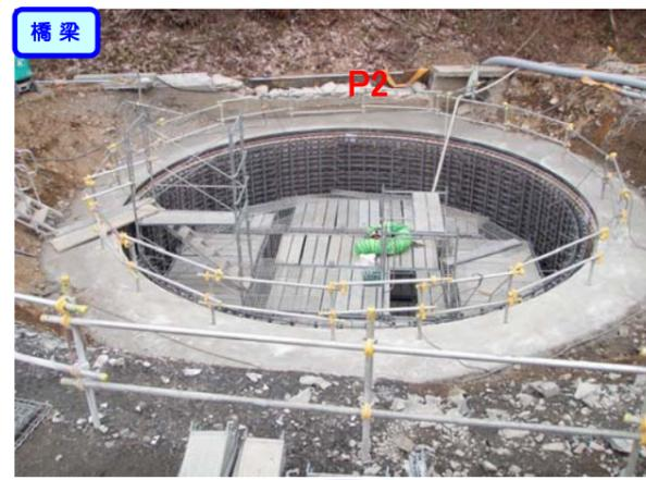
橋脚施工に先立ち大口径深礎杭の鉄筋組立作業をしています。
