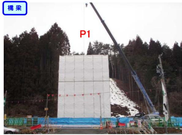
鉄筋・型枠資材をクレーンで荷揚げしています。
