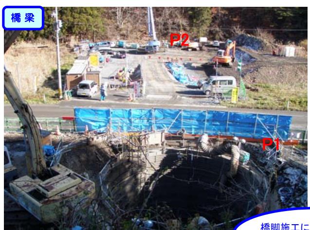
橋脚施工に先立ち大口径深礎杭を施工中です。
