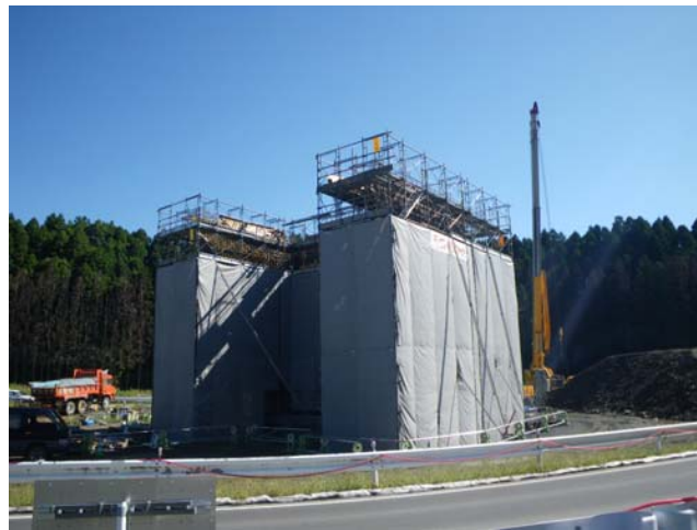
② No.0から1号橋を望む 1号橋 全景
