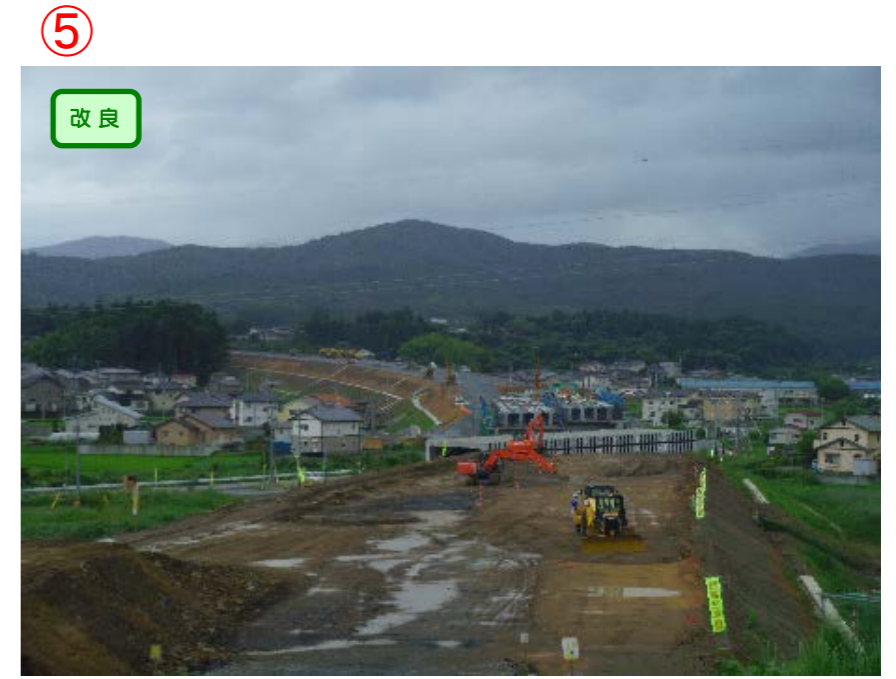
▲No.542より起点側を望む
