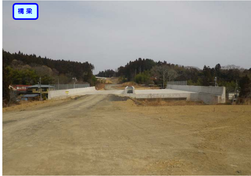
▲No.227から終点側を望む [滝根川橋(仮)]
