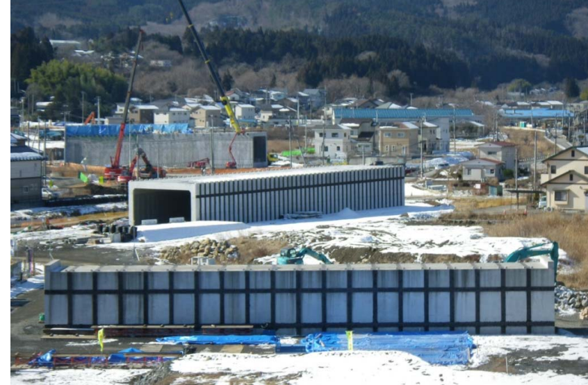
改良 ③ No.542より起点側を望む
