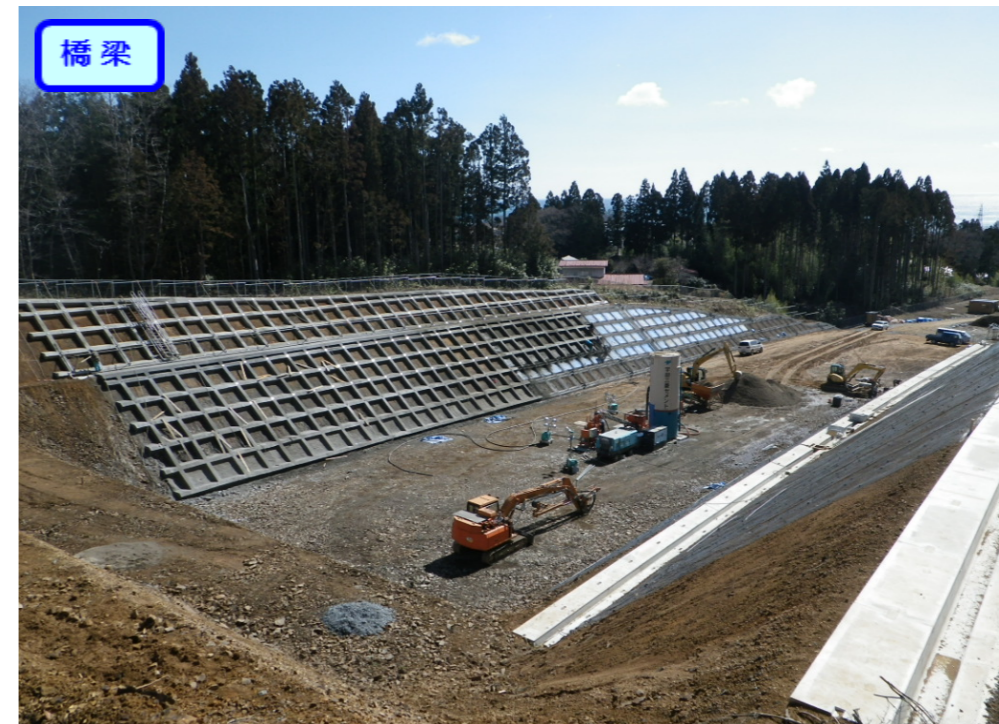
② No.248から起点側を望む
