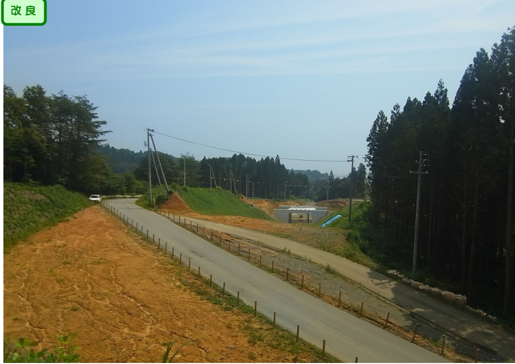
③ 縦貫道No.1から終点側を望む
