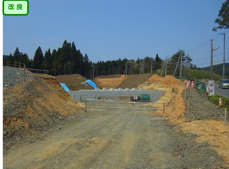
② 縦貫道No.14から起点側を望む
