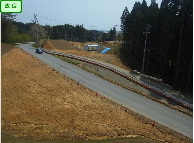
③ 縦貫道No.1から終点側を望む
