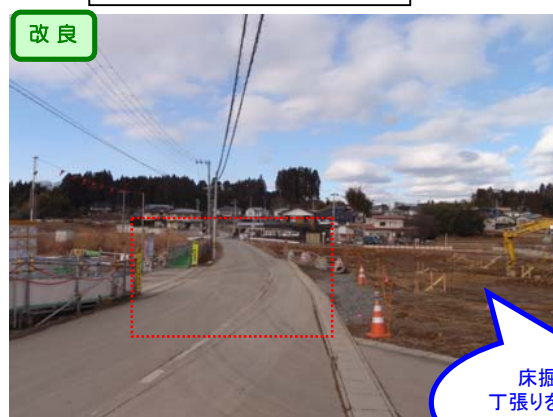
③ 右側からNo.520を望む 第15号道路函渠工
