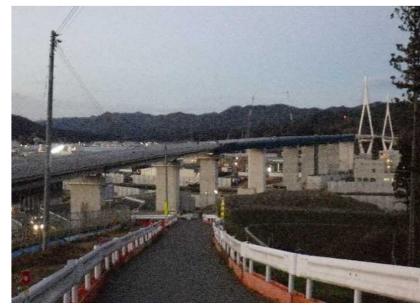
▲No.115付近から終点側を望む [気仙沼湾横断橋 P4～P11]
