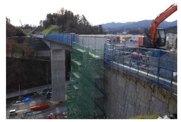
▲No271から終点側を望む [鹿折橋(仮)]
