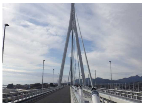
▲No.150付近から起点側を望む [気仙沼湾横断橋 P11～P12]
