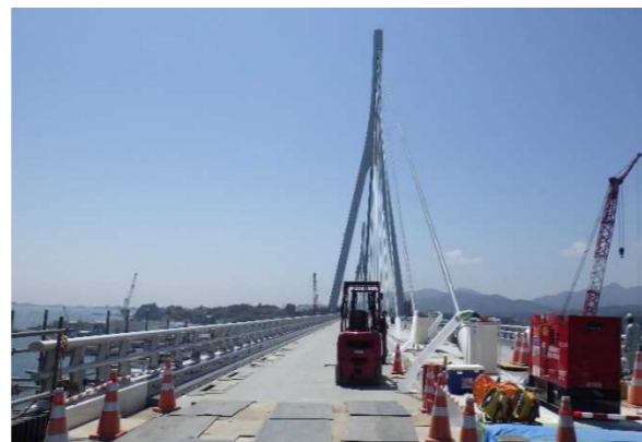
▲No.150付近から起点側を望む 〔(仮)気仙沼湾横断橋 P11～P12〕
