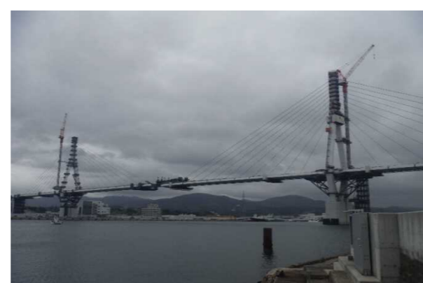
▲No.150付近から起点側を望む 〔(仮)気仙沼湾横断橋 P11～P12〕
