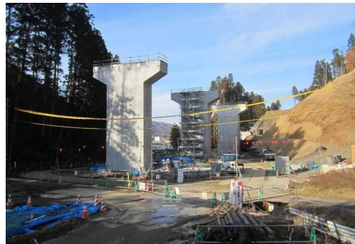
▲No.228から終点側を望む [浪板大橋(仮)]
