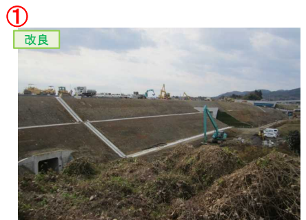
▲No.16北側から本線を望む [左: 第4号道路函渠] [右: 第3号道路函渠]
