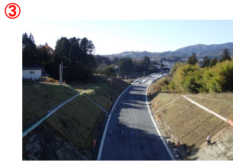
▲第2号跨道橋から本線を望む
