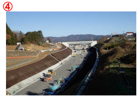
▲第2号跨道橋から本線を望む
