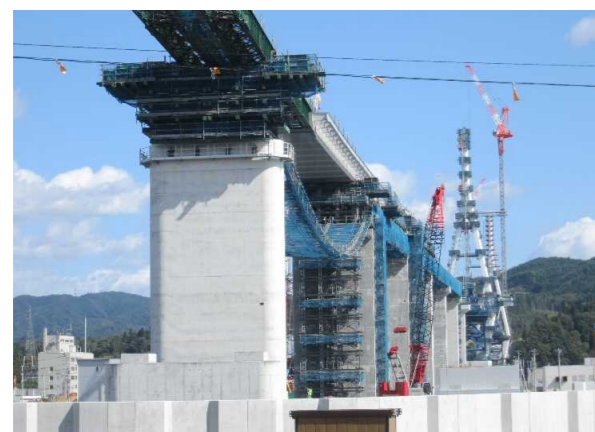
▲No.90付近から終点側を望む 〔(仮)気仙沼湾横断橋 P4～P12〕
