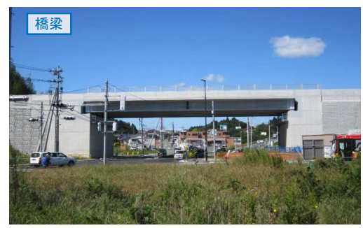
▲No.27南側から本線を望む [片浜跨道橋(仮)]
