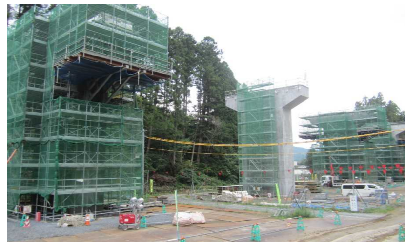
▲No.228から終点側を望む [浪板大橋(仮)]
