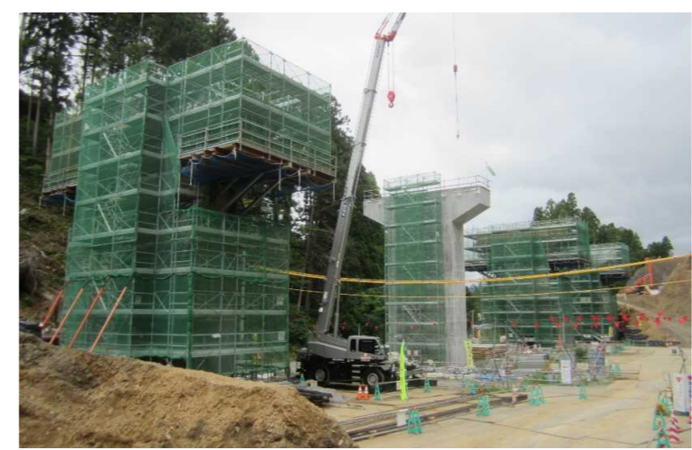
▲No.228から終点側を望む [浪板大橋(仮)]
