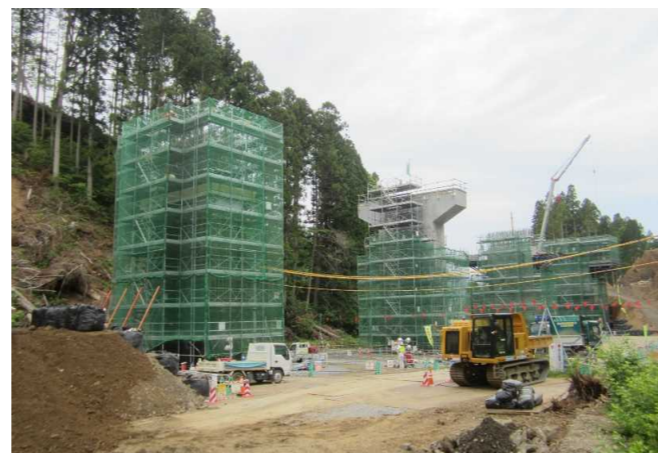
▲No.228から終点側を望む [浪板大橋(仮)]
