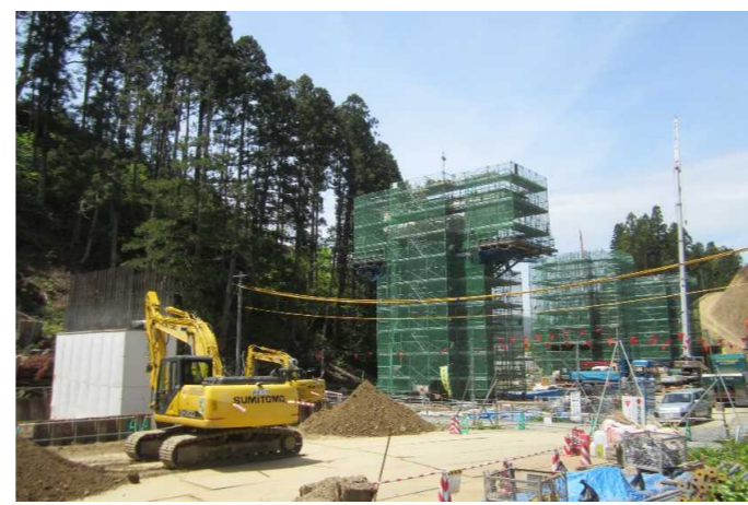
▲No.228から終点側を望む [浪板大橋(仮)]
