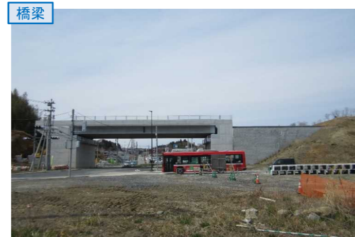
▲No.27南側から本線を望む [片浜跨道橋(仮)]
