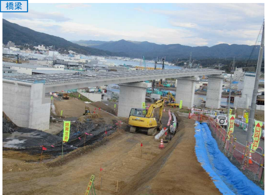
▲No.80東側から終点側を望む 〔(仮)気仙沼湾横断橋〕
