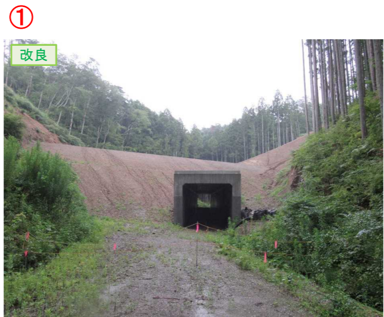
▲No.210西側から本線側に望む [第11号道路函渠]
