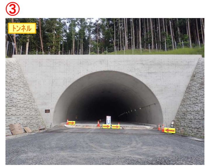
▲No.148から起点側を望む [県境トンネル(仮)]
