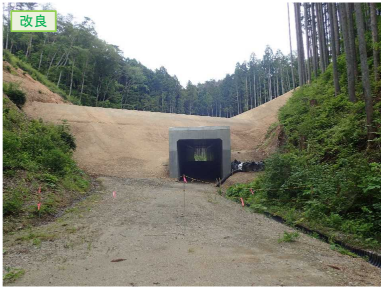
▲No.210西側から本線側に望む [第11号道路函渠]
