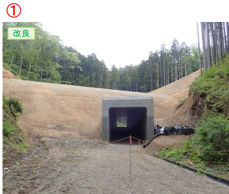
▲No.210西側から本線側に望む [第11号道路函渠]
