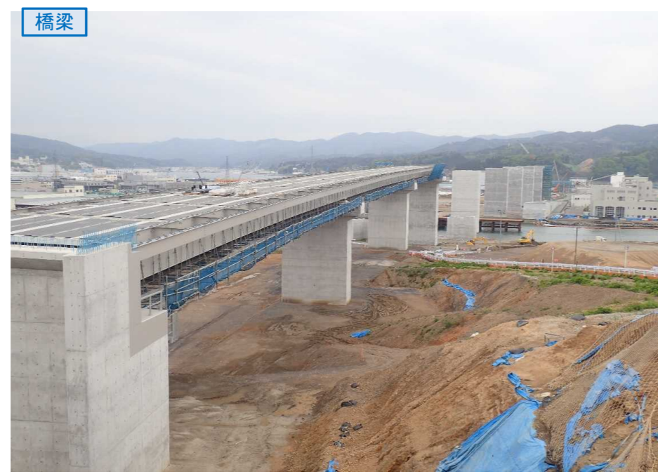
▲No.80東側から終点側を望む 〔仮〕気仙沼湾横断橋
