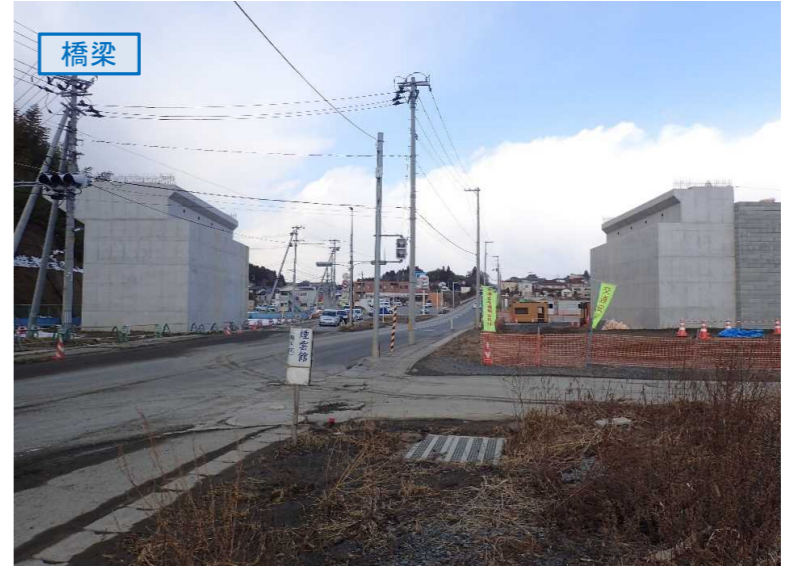
▲No.27南側から本線を望む [片浜跨道橋(仮)]
