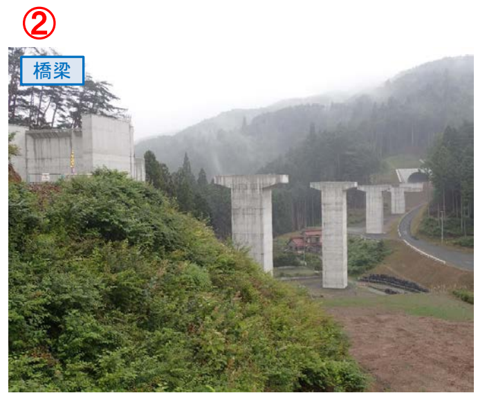
▲No.80東側から終点側を望む [青野沢川橋(仮)]
