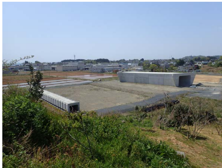
▲No.16北側から本線を望む
