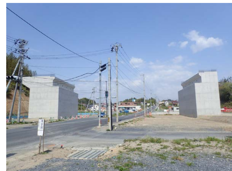
▲No.27南側から本線を望む [片浜跨道橋(仮)]
