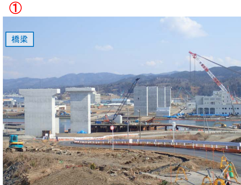
▲No.83東側から終点側を望む 気仙沼湾横断橋(仮)
