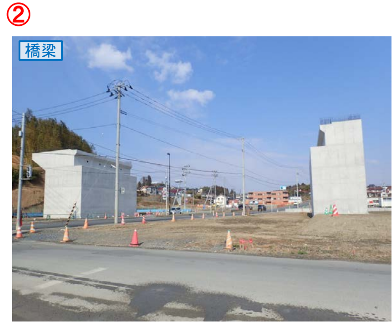
▲No.27南側から本線を望む [片浜跨道橋(仮)]
