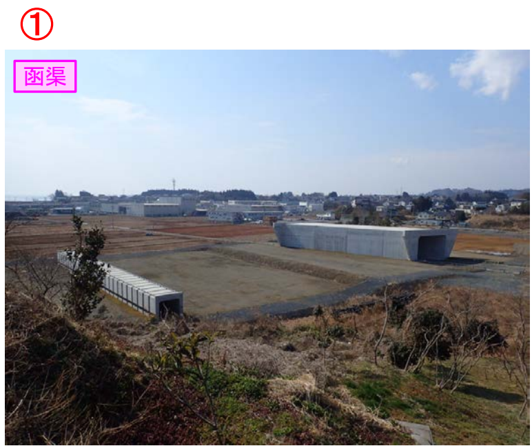
▲No.16北側から本線を望む
