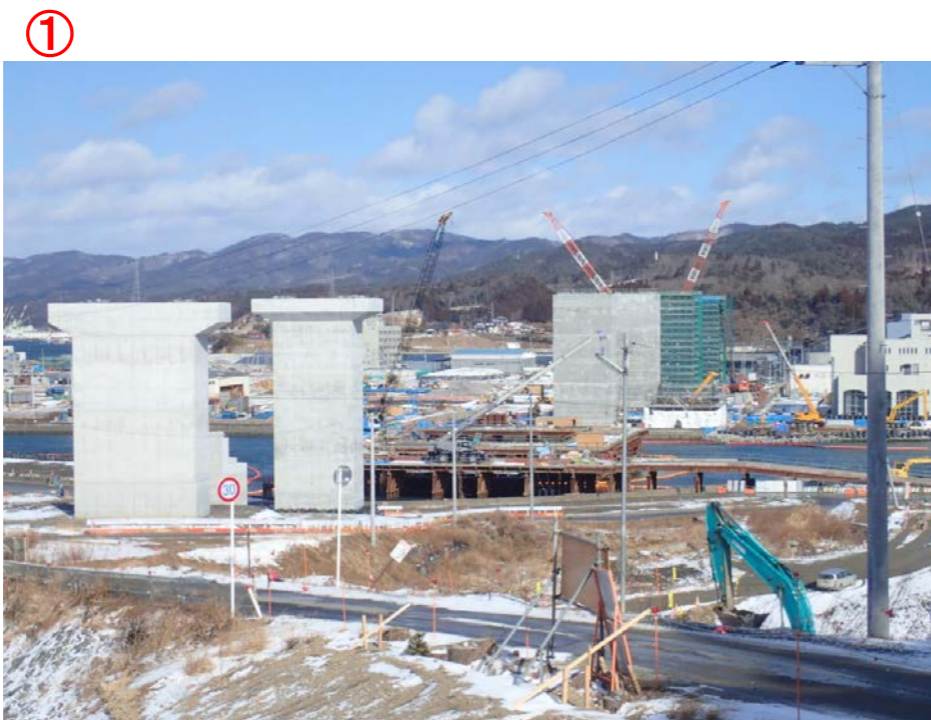
▲No.83東側から終点側を望む
