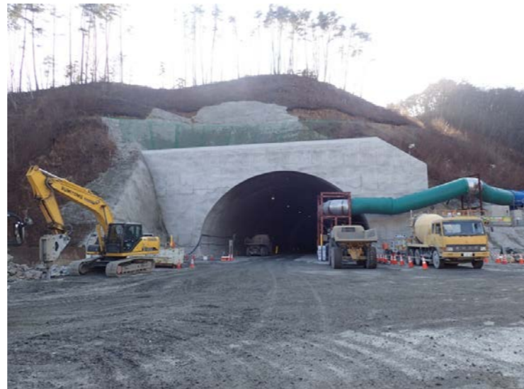
▲No410から坑口を望む
