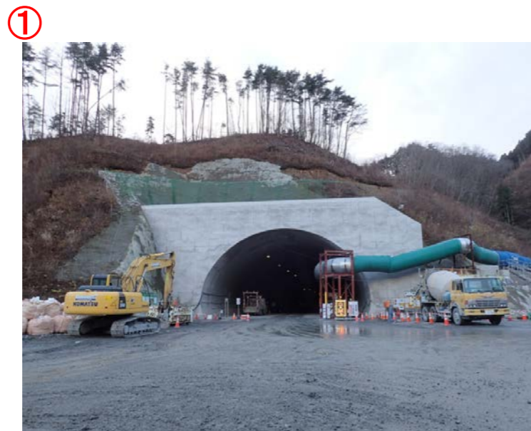
▲No410から坑口を望む
