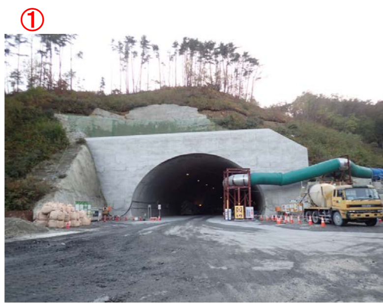
▲No410から坑口を望む
