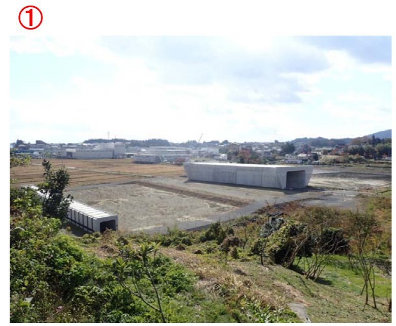
▲No.16付近から起点側を望む
