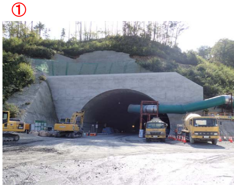
▲No410から坑口を望む
