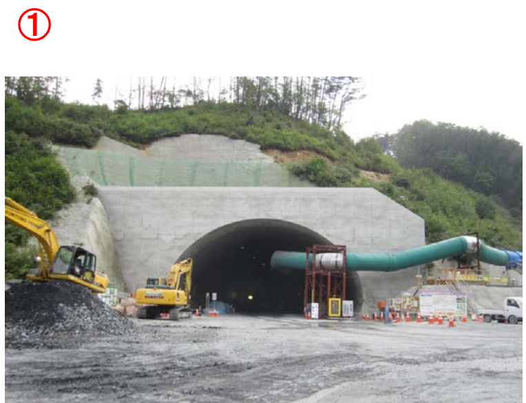
▲No410から坑口を望む
