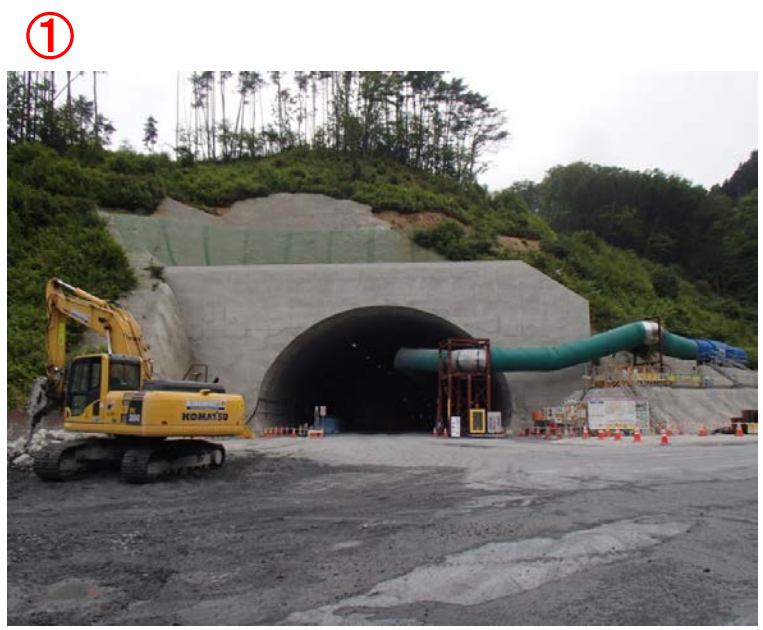
▲No410から坑口を望む
