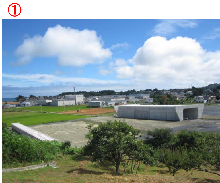
▲No.16付近から起点側を望む
