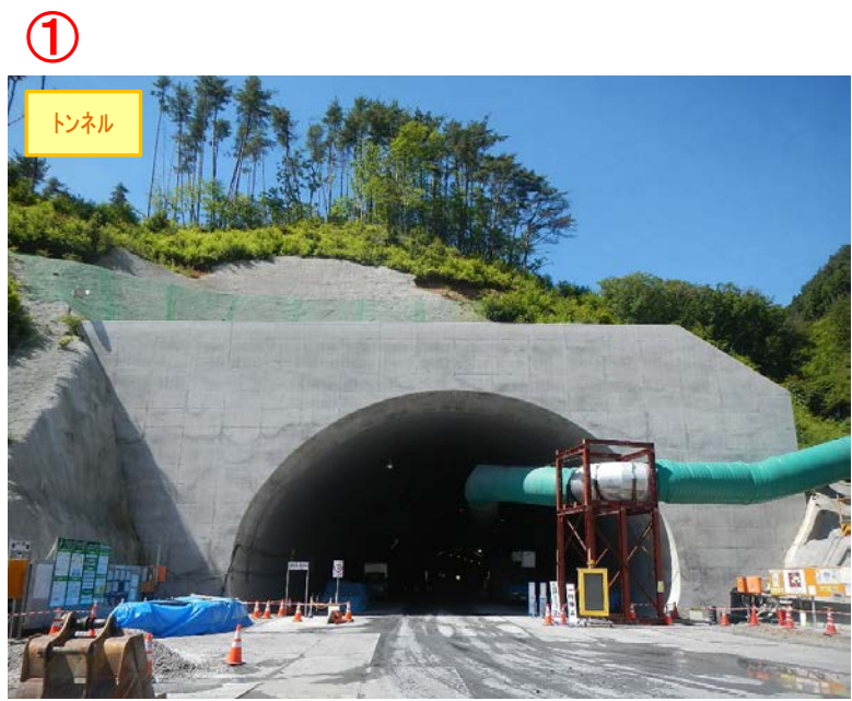
▲No410から坑口を望む
