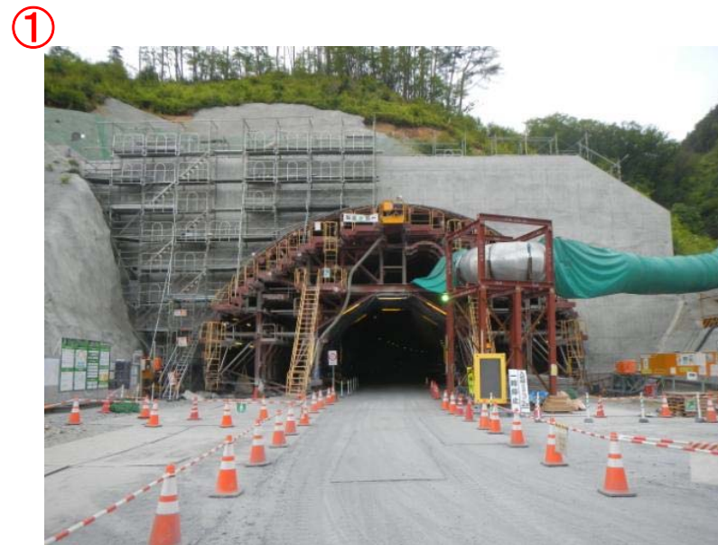
▲No410から坑口を望む
