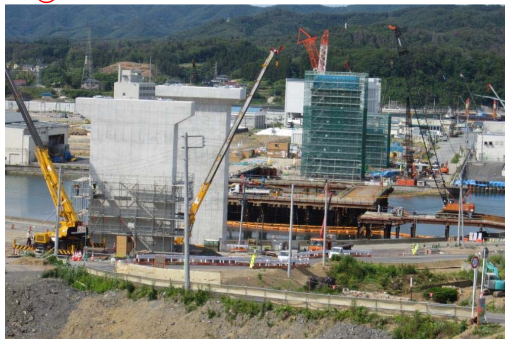
▲No.83付近から終点側を望む
