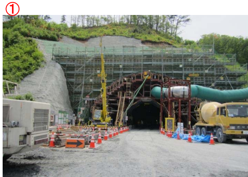
▲No410から坑口を望む
