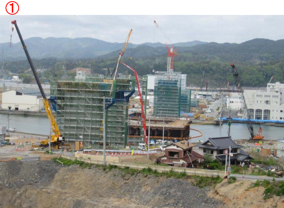
▲No.83付近から終点側を望む
