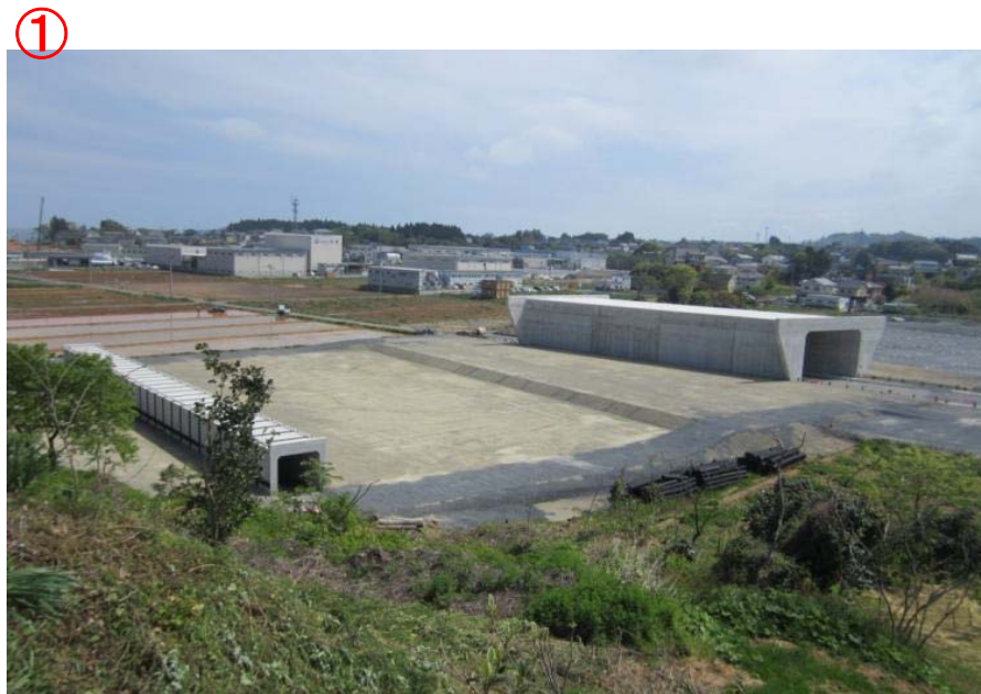
▲No.16付近から起点側を望む
